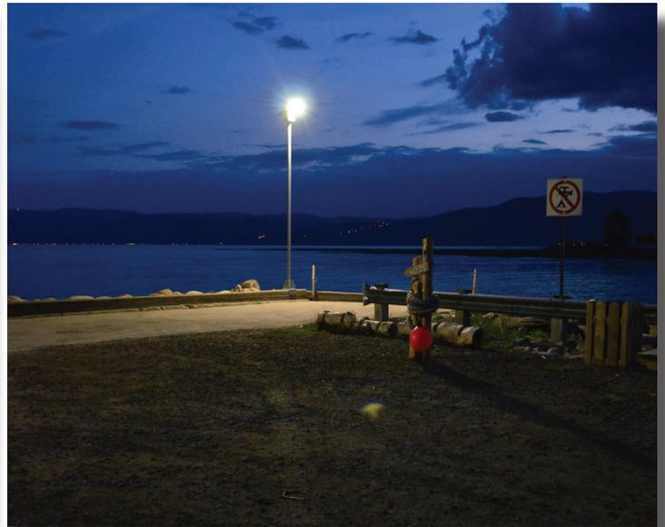
Les luminaires « **LX25** » sont les appareils d'éclairage solaires les plus évolués sur le marché. Ils intègrent dans un même boîtier la plus récente technologie d'éclairage à DEL de Philips, un détecteur de présence, un module solaire, un contrôleur intelligent ainsi qu'une pile. Il n'y a aucun câblage, ni raccordement électrique nécessaire.
